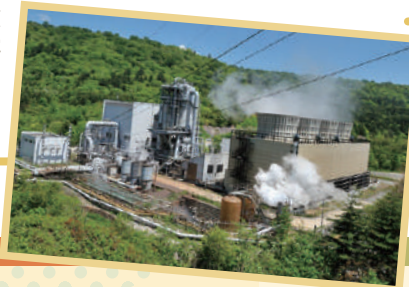
鬼首地熱発電所 (宮城県大崎市)
