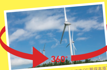
にかほ第二風力発電所(秋田県にかほ市(仁賀保高原))
